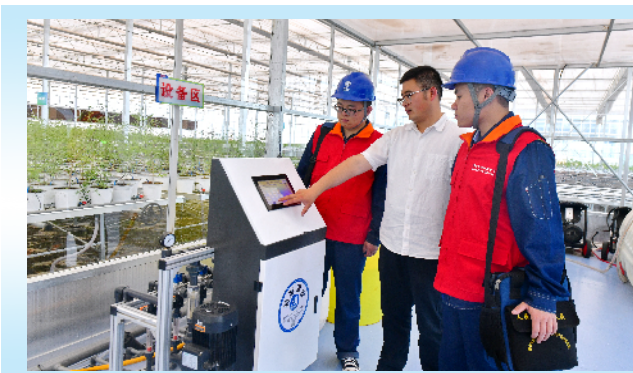
图为 6 月 20 日，甘肃白银供电公司工作人员对文冠果现代农业全产业链示范基地开展用电检查，保障基地安全生产用电。乔卫明/摄
